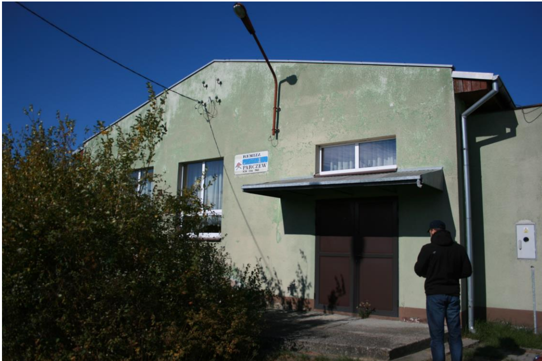
Widok elewacji frontowej od strony wjazdu na działkę – elewacja południowa.
