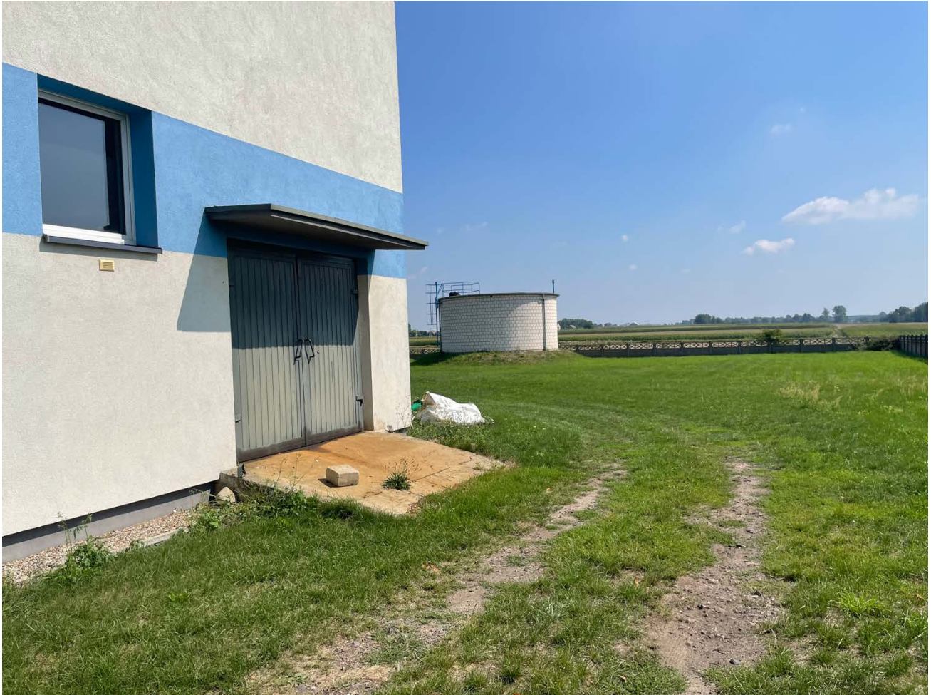
Rysunek 1 Stacja uzdatniania wody w Sieroszewicach – miejsce budowy instalacji fotowoltaicznej (grunt)
